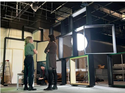
Écosceno a accompagné les équipes du MEM dans la création de son centre d'expositions temporaires. Les équipes ont fait des recherches et des tests pour développer une structure modulaire assemblée mécaniquement, permettant de varier les configurations au fil du temps. Nous avons collaboré avec Bois Public dans l'approvisionnement de bois de frêne revalorisé.
